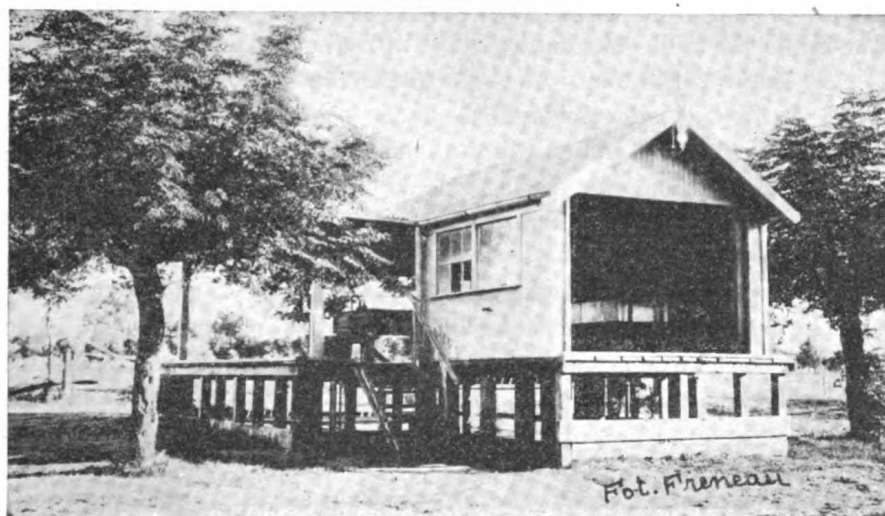
FOTOGRAFIA 3. — Fábrica de queso «Carcañá». (Pcia. Santa Fé). Vista del tinglado para recibo de la leche y del lavadero de tarros. En primer plano la planchada para recibo con su «tanque-balanza». En segundo término, el lavadero de tarros con sus tanques de madera.
