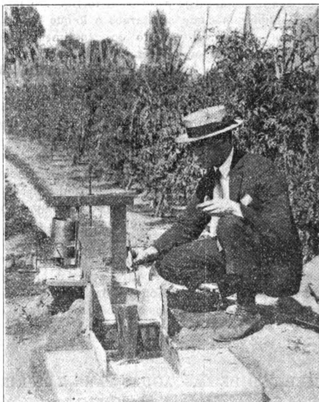
El medidor registrador de las aguas para el riego.—Durante uno de los riegos.—Control del aparato y medida del tiempo.
