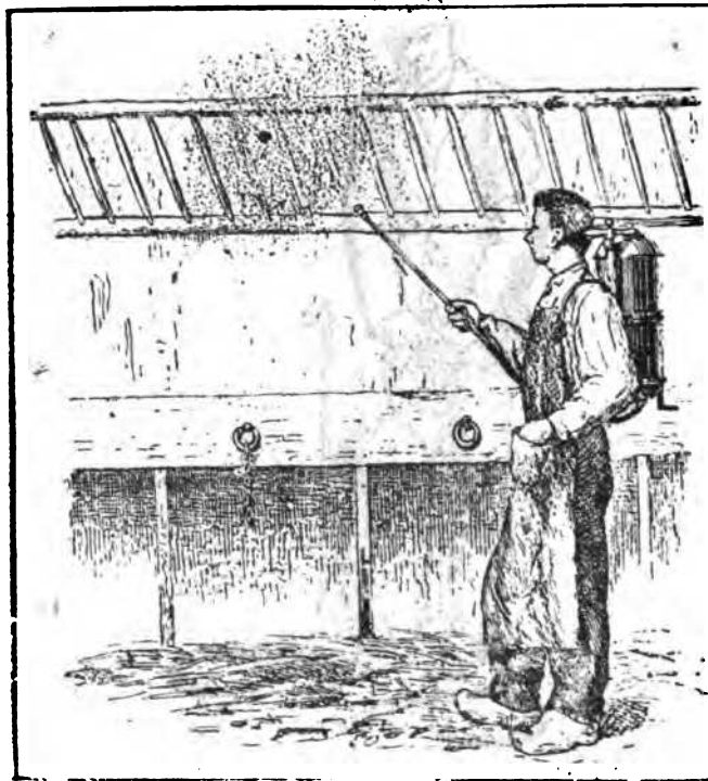
Fig. 135. Como se hace la desinfección con el pulverizador. Los brazos del operador se hallan completamente libres.
