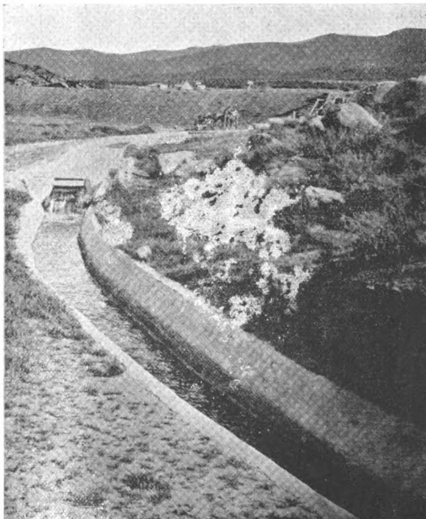
Canal de riego forrado en cemento en California, E. U. A.
